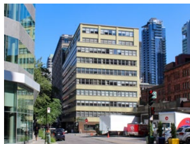
1450, rue City-Councillors 1435, rue Saint-Alexandre Montréal
