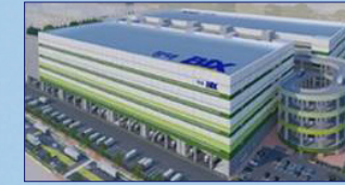
평택 포승지구 물류부지 (평택시 / 대지면적 : 91,950㎡)
